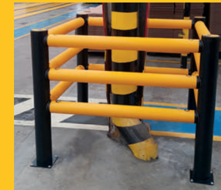
Colonna tipo iFlexRail a protezione di un pluviale presente in un magazzino di distribuzione in area pedonale.
