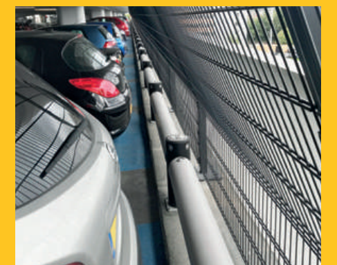
Barriera iFlex Traffic alta per la protezione perimetrale di un parcheggio multipiano.
